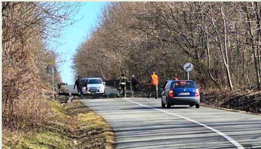
V spolupráci s urbárskym spolokom sa realizovalo čistenie cesty do hĺbky tri metre za okraj cesty, aby sa zvýšila viditeľnosť na prechádzajúcu zver a zabezpečila sa lepšia bezpečnosť prejazdu autom v tomto úseku
