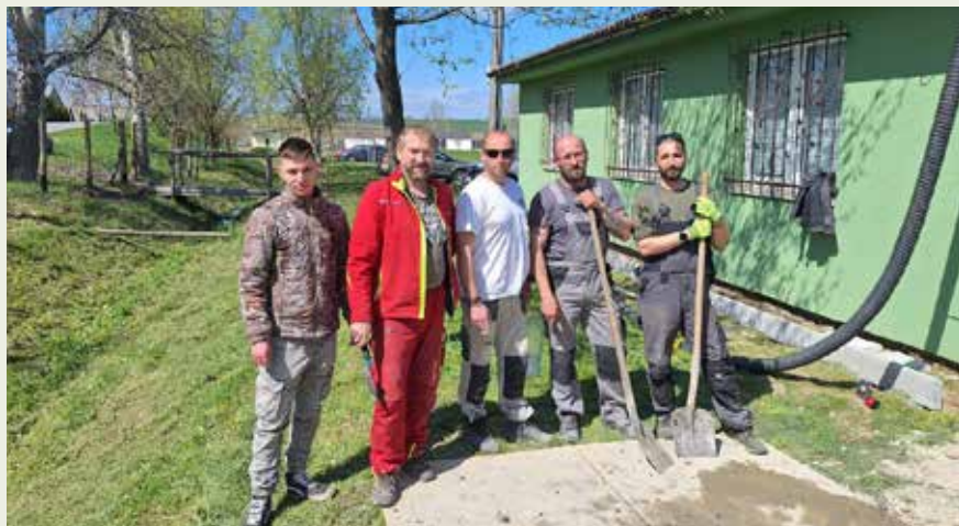
Inštalácia obrubníkov medzi areálom Poľovníckeho domu Šarina a tenisovými kurtami
