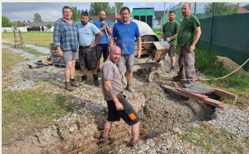
Inštalácia základov brány do areálu Poľovníckeho domu Šarina
