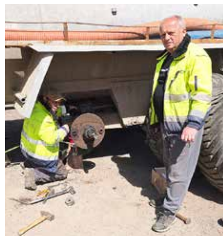
Obecní pracovníci pri oprave fekála
